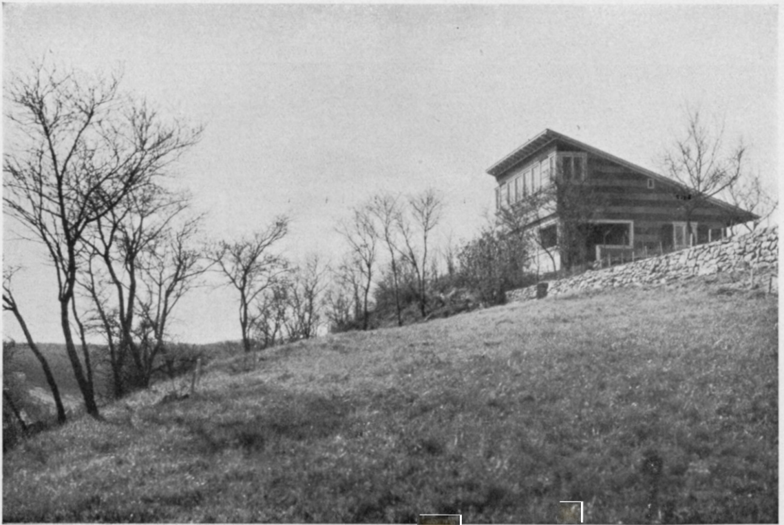
Wochenendhaus in Waldenbuch bei Stuttgart (siehe auch Seite 92). Erbaut 1928 in Thermo-Plattenfachwerk mit Asbestschiefer-Verkleidung. Entwurf: Regierungsbaumeister Walther Rist, Mitarbeiter: Dipl.-Ing. Theo Klemm Oben: Westseite Unten: Südostseite
